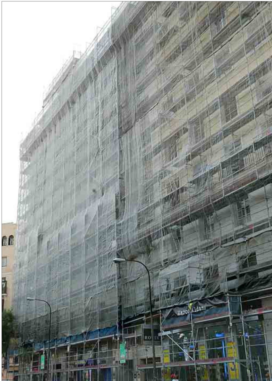
Obras de rehabilitación en un edificio en un barrio céntrico de Madrid. / ANTONIO HEREDIA
