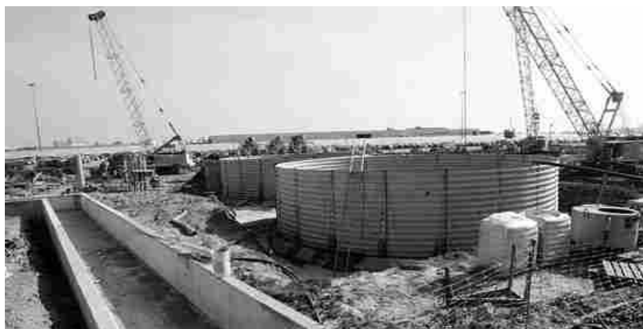
La nova planta de tractament s'està construint al costat de la depuradora de Vila-seca. / JUDIT FERNÁNDEZ
