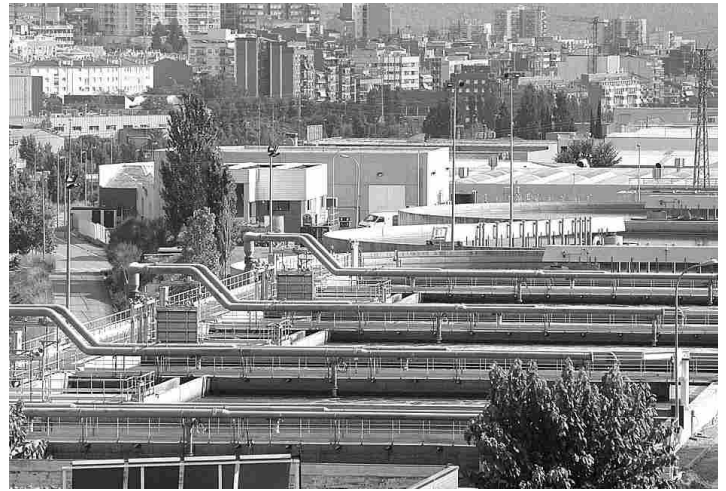
La ampliación de la depuradora dará respuesta al crecimiento de la ciudad. ARCHIVO
